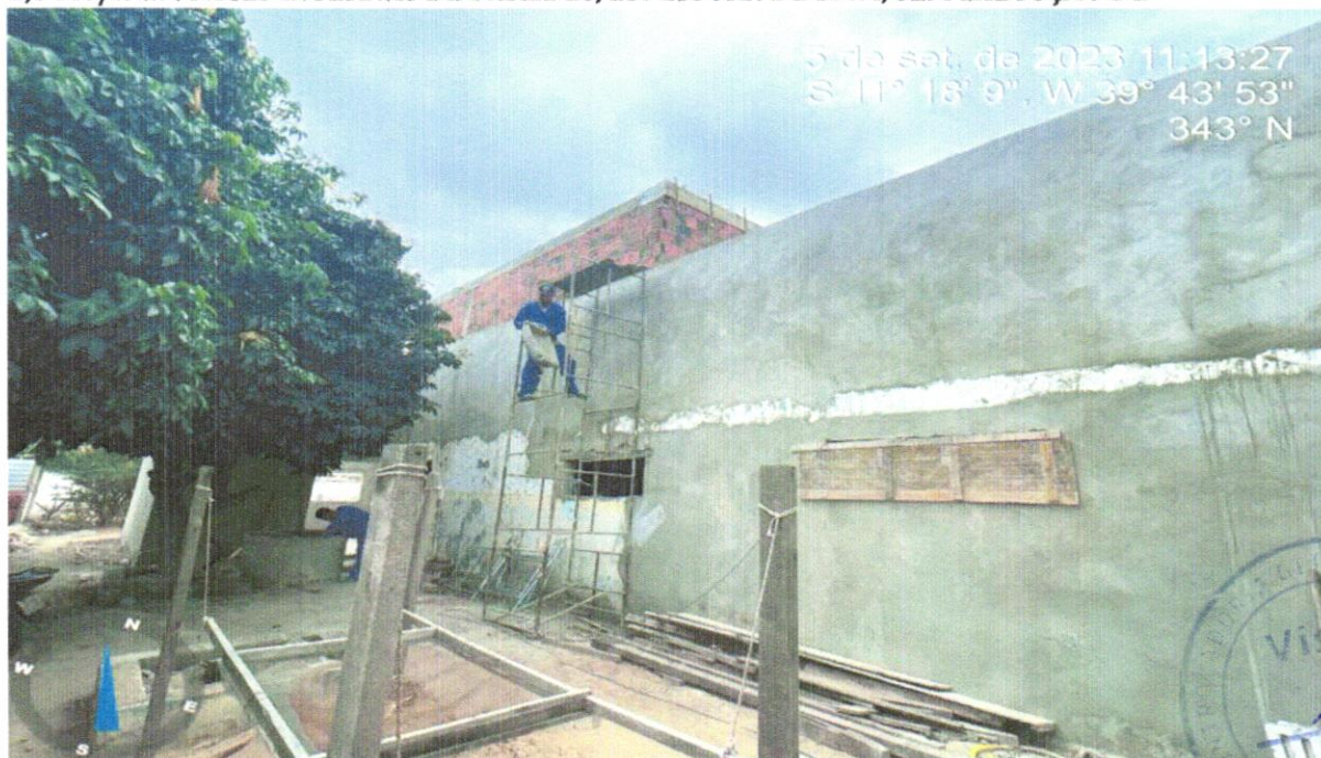
FOTO 22 - MASSA ÚNICA, PARA RECEBIMENTO DE PINTURA OU CERÂMICA, ARGAMASSA INDUSTRIALIZADA, PREPARO MECÂNICO, APLICADO COM EQUIPAMENTO DE MISTURA E PROJEÇÃO DE 1,5 M3/H EM FACES INTERNAS DE PAREDES, ESPESURA DE 5MM, SEM EXECUÇÃO DE
