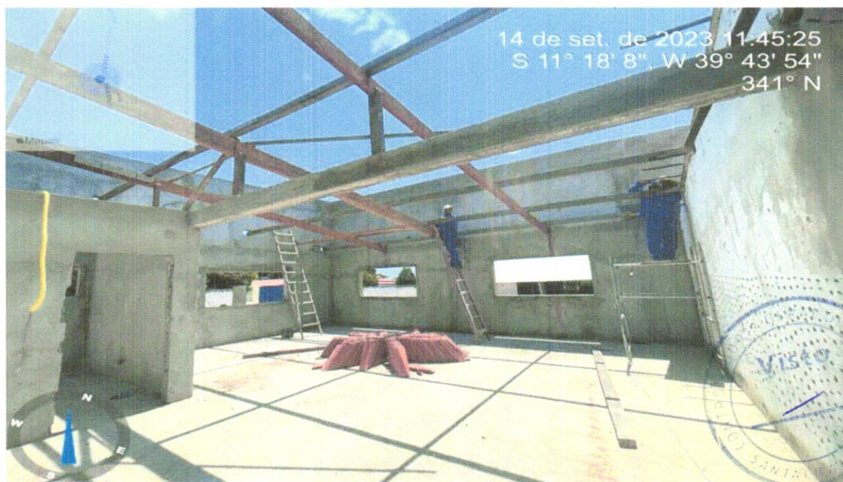
FOTO 06 - TRAMA DE MADEIRA COMPOSTA POR RIPAS, CAIBROS E TERÇAS PARA TELHADOS DE MAIS QUE 2 ÁGUAS PARA TELHA CERÂMICA CAPA-CANAL, INCLUSO TRANSPORTE VERTICAL.
