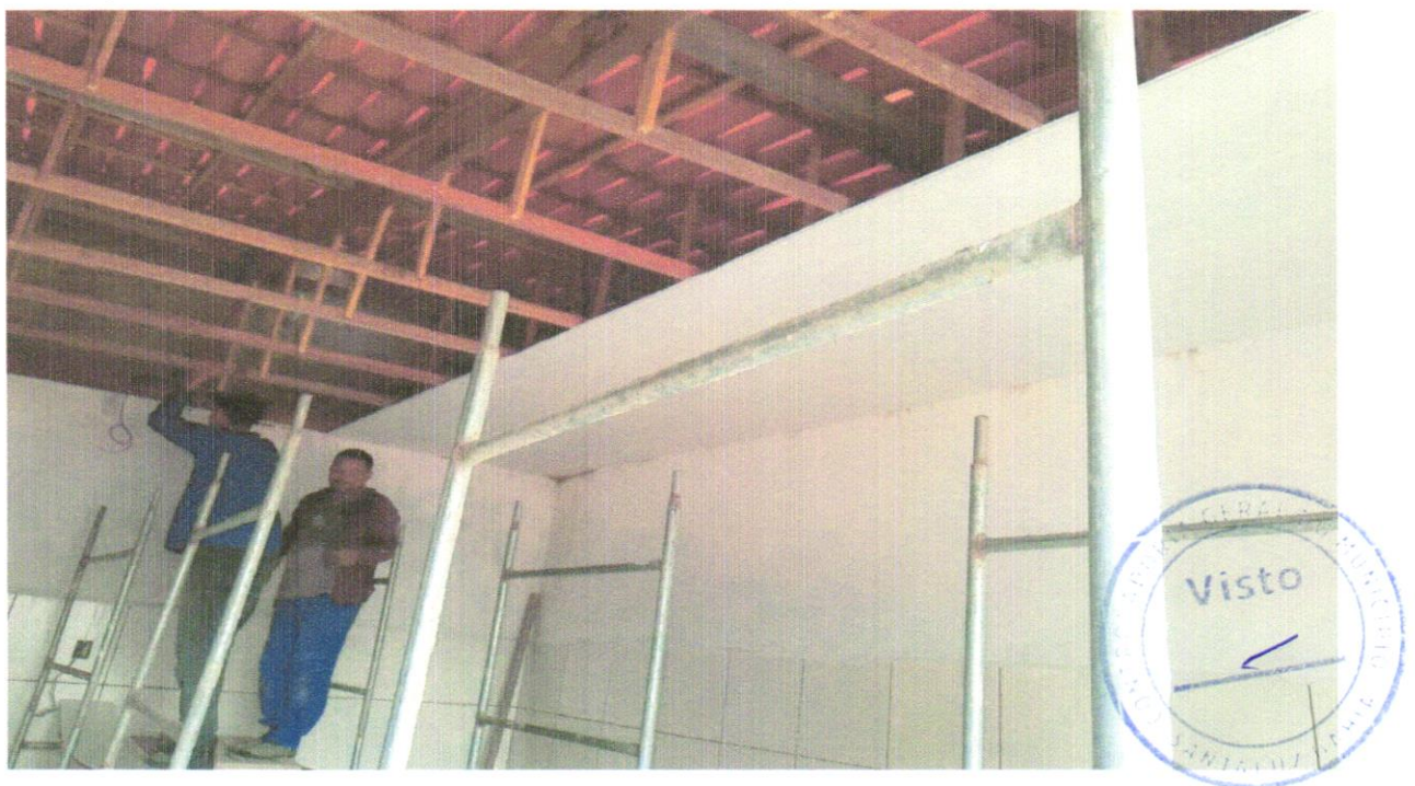
FOTO 10 - Forro de pvc, em régulas de 10 ou 20 cm, aplicado, inclusive estrutura para fixação (perfis em PVC) marca Araforros ou similar, instalado - Rev 06_10/2021 AF_06/2016_P
