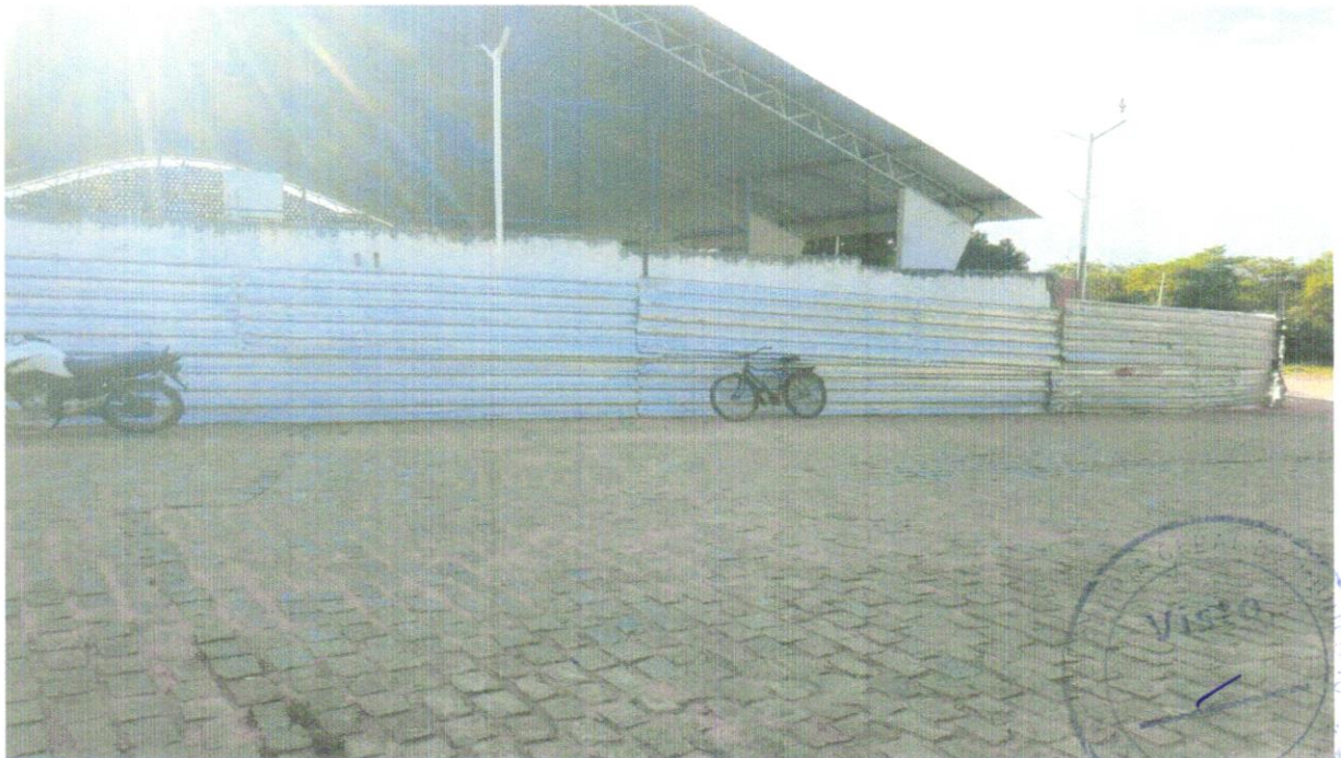
FOTO 04 - TAPUME COM TELHA METÁLICA. AF_05/2018
