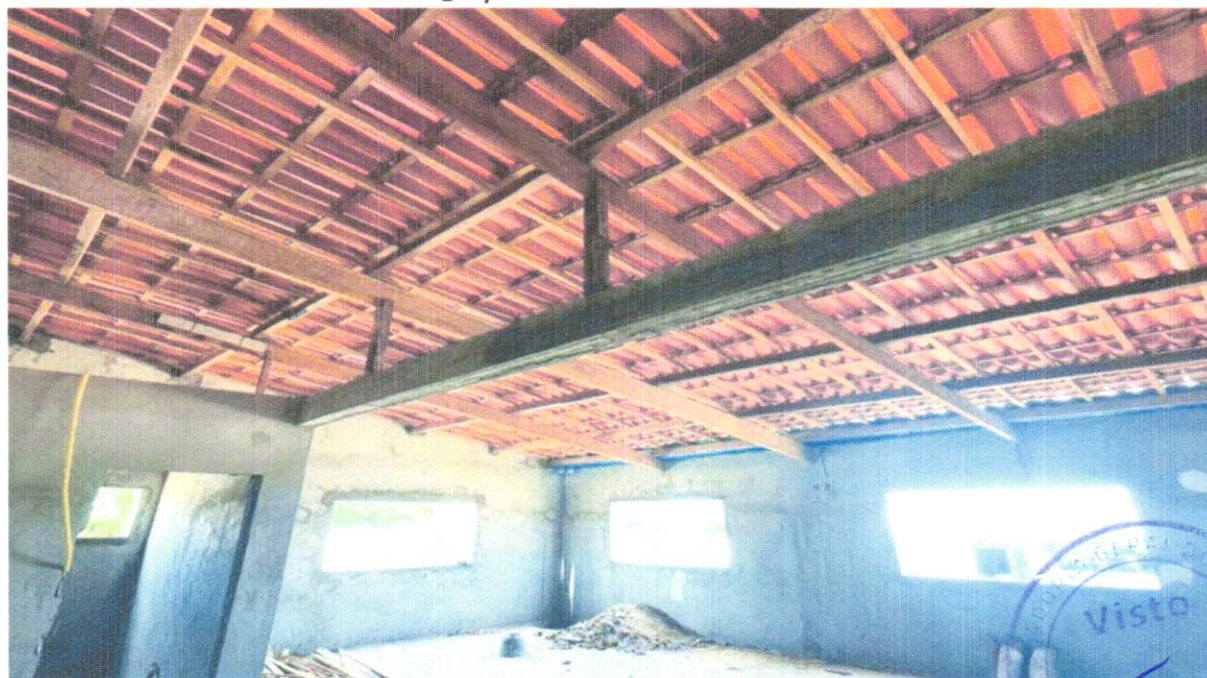
FOTO 08 - TELHAMENTO COM TELHA CERÂMICA DE ENCAIXE, TIPO ROMANA, COM ATÉ 2 ÁGUAS, INCLUSO TRANSPORTE VERTICAL. AF_07/2019
